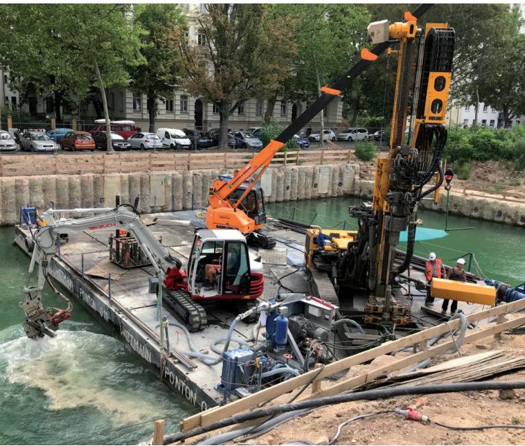
Arbeiten an einer Unterwasser- betonsohle in Leipzig
